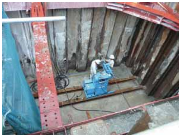
大地震に備えた地盤改良工事
