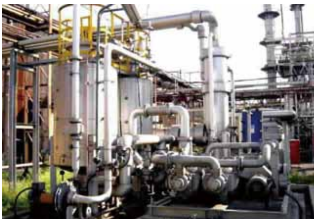
揮発性有機化合物回収設備では、濃縮・吸着などさまざまな方法で大気汚染を防止します。
