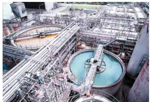
排水処理設備では、工場排水に含まれる水質汚濁物質を微生物の働きで除去します。
