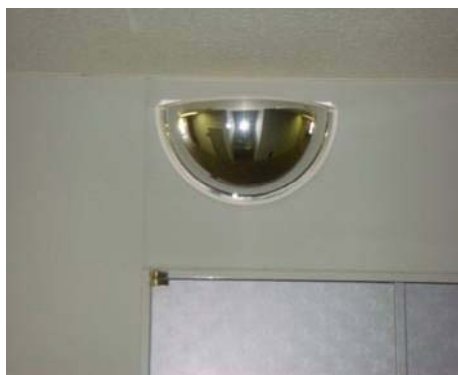
建物内通路ミラーで確認
