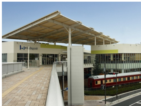
CSA 施工事例：ららぽーと新三郷
