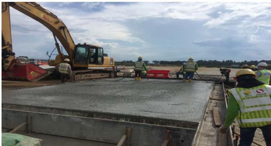
シンガポールチャンギ空港滑走路の施工風景
