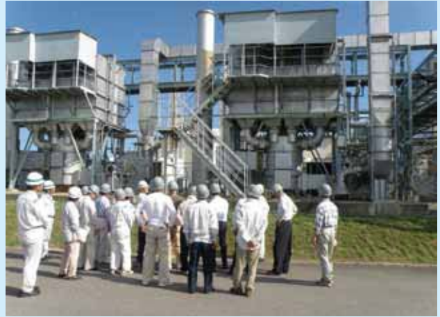
蓄熱式脱臭装置（事業所工場見学会にて）
