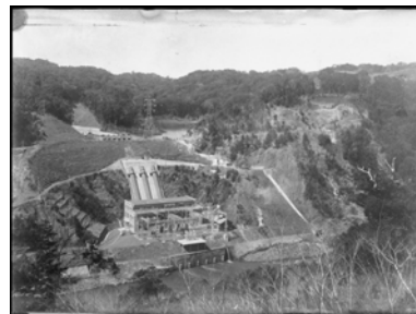
大牟田工場に電力を供給するために建設した大淀川第一発電所(大正15年)
