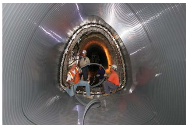
図8. アメリカでの施工写真
