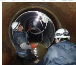
下水供用下での施工事例
