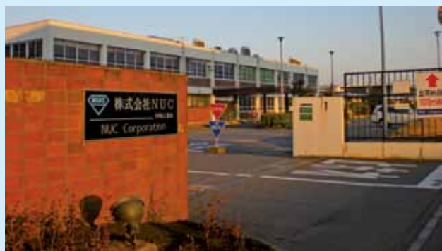
リニューアルされた工場正門
