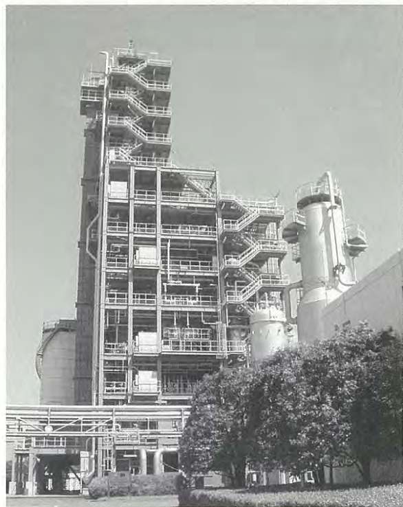
使用済プラスチックのリサイクルプラント(アンモニア製造設備)
