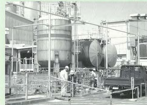
ブタンガス転換のため安全工事中の発泡剤タンク
