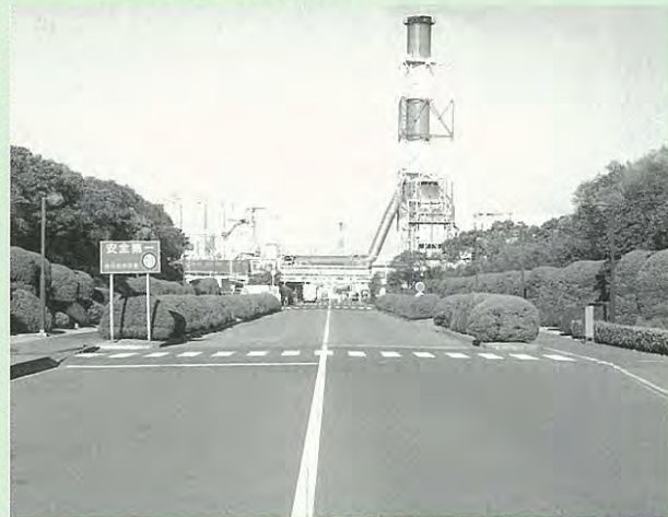
工場入口付近
