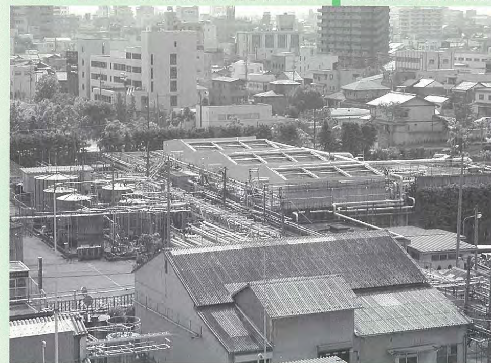
▲排水処理施設の臭気対策カバー（中央部。市街地を背景に）
