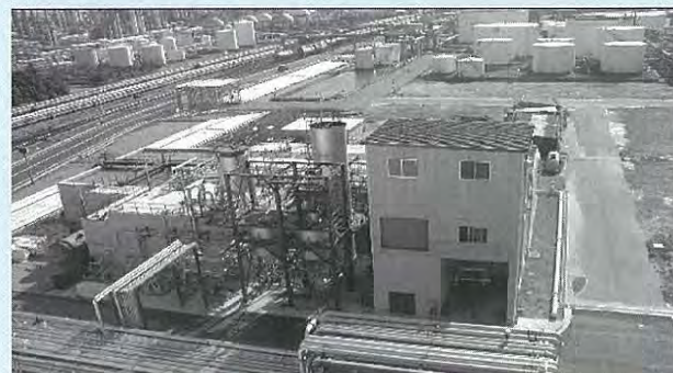
▲北地区排水処理設備
