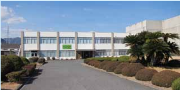
大竹工場（事務棟）
