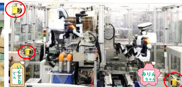
エリアセンサーの設置
