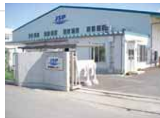
鹿沼事業所 再資源センター (外観)
