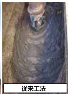
掘削時の従来工法（ゴテゴテ粘性）とECO-MW工法（サラサラ粘性）との違い
