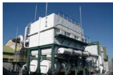
合成ゴム乾燥排気の燃焼設備
