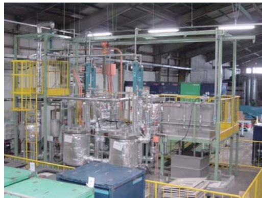
FRP リサイクル実証プラント
