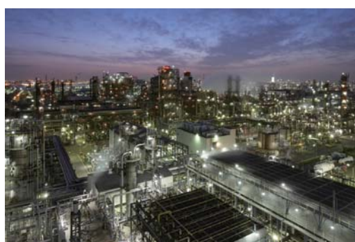
東燃化学株川崎工場
