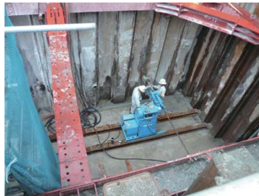
地盤改良耐震工事（JSR株千葉工場） 設備の耐震性能診断を行い、計画的に耐震工事を行っています。
