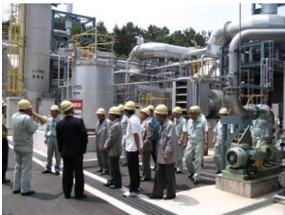
環境の取り組みに関する説明会での設備見学
