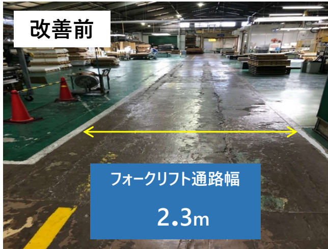
シート工場床面補修と通路幅拡大
