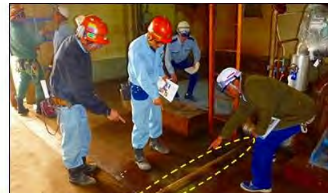
工事詳細手順の現地確認
