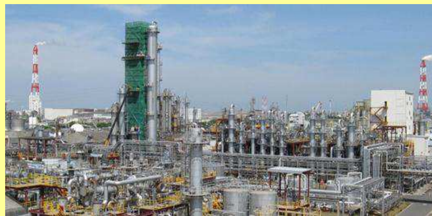
現在の蒸留塔群
