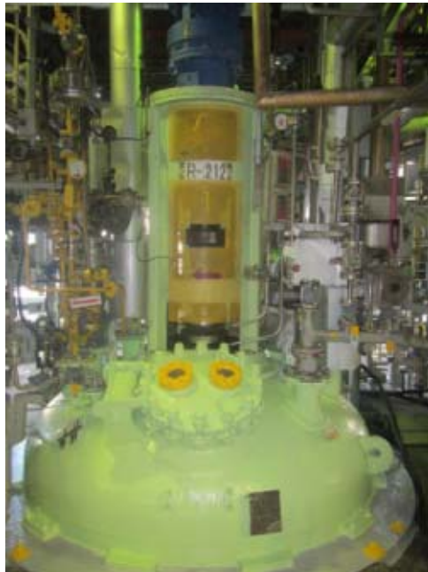
攪拌機回転確認点検口を開閉タイプから網タイプに
